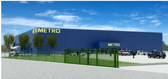
Montea «Space for Growth» - site Vorst - Metro (BE)
