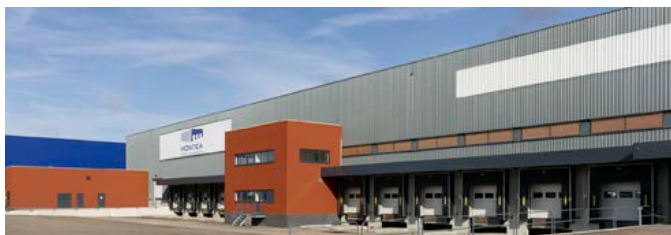
Montea «Space for Growth» - Site Puurs Schoonmansveld 28
